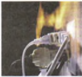
Рис. 89. Короткое замыкание в электропроводке
