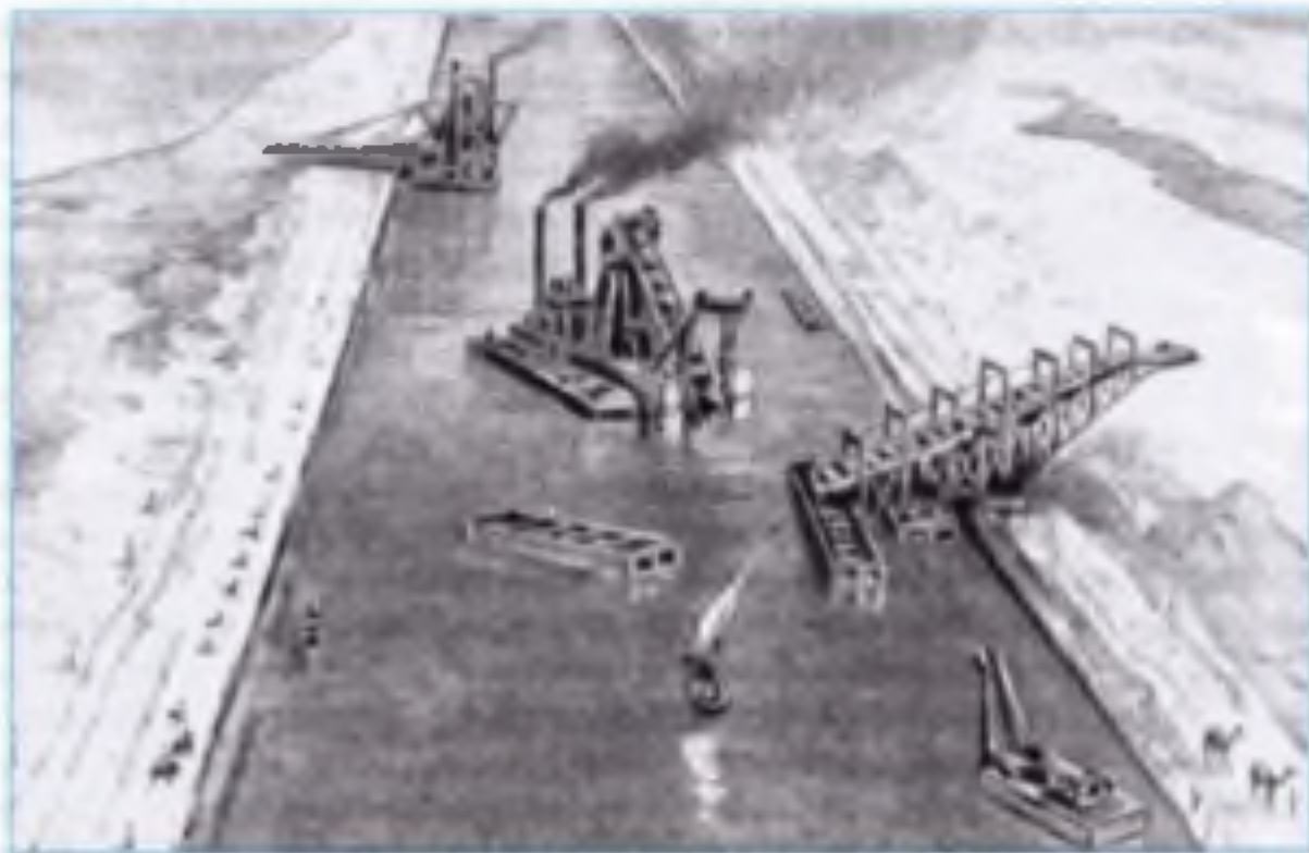
Строительные работы на Суэцком канале. Открытый в 1869 г. канал соединил Красное и Средиземное моря
