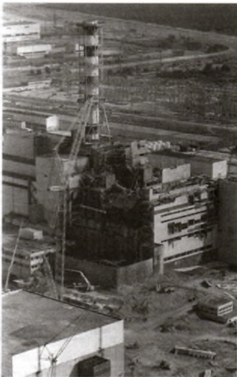
Возведение защитной стены после аварии на 4-м энергоблоке Чернобыльской АЭС
