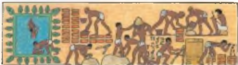
Строительство дома. Древнеегипетская роспись.
